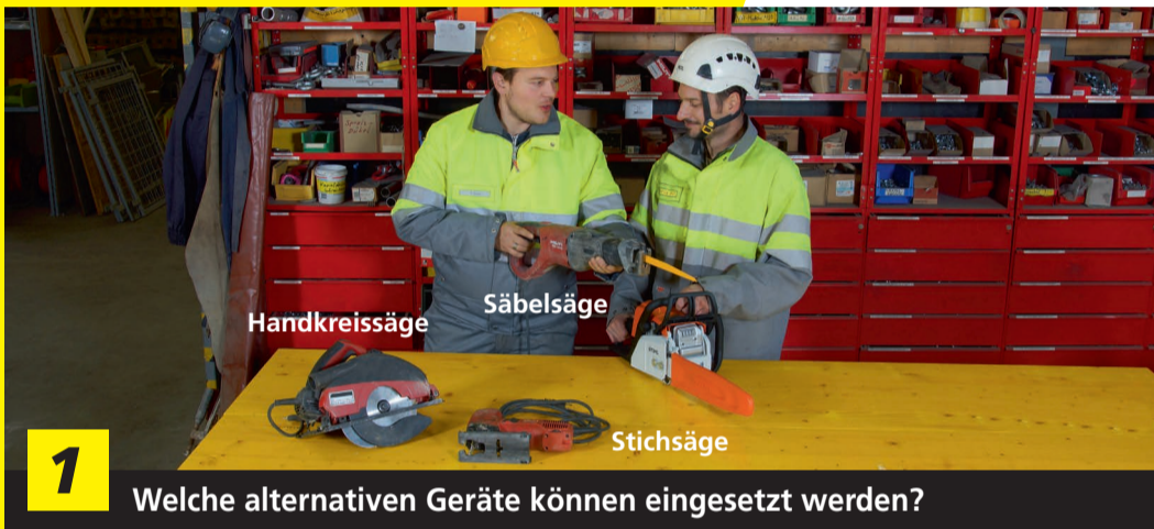
7 Trennschnitt von Kantholz korrekt anwenden
