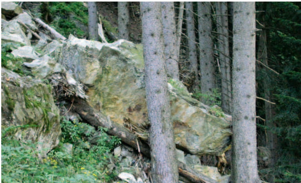
Schutz gegen Steinschlag
